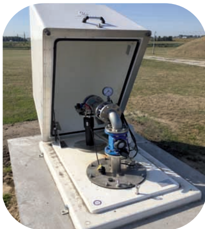
Armatura wewnętrzna studni
