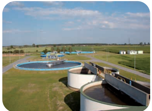
Oczyszczalnia ścieków w Chwałkowie
