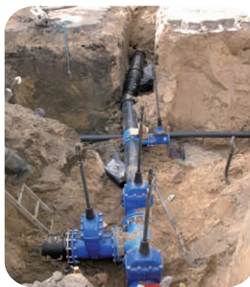
Wymiana sieci wodociągowej. W latach 2012 - 2017 wymieniliśmy 16 km sieci wodociągowej w ramach realizacji zadania pod nazwą „Kontynuacja rozbudowy kolektorów sanitarnych wraz z wymianą sieci wodociągowych w aglomeracji Środa Wlkp.”
