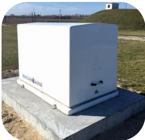
Nowa obudowa studni
