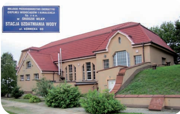
Budynek Stacji Uzdatniania Wody w Środzie przy ul. Kórniczej
